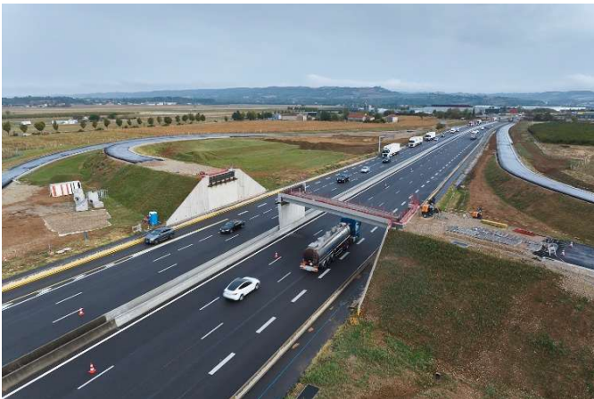
Pose des poutres sens Lyon :Marseille
